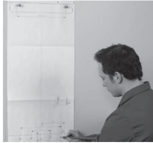
1. Предварительная разметка с помощью монтажного шаблона
